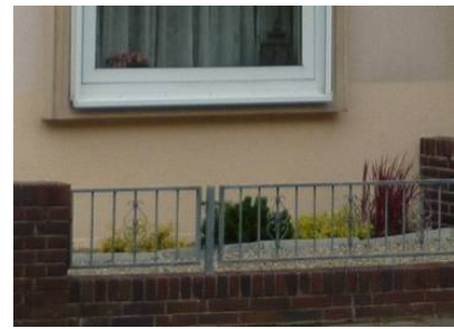
Mauer mit Metallelement
