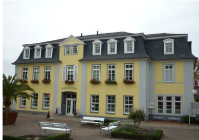
3-geschossiges, historisches Gebäude
