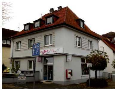
Walmdach mit Gauben
