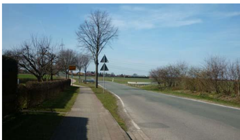
Ortseingang West, Foto aus Planunterlage der ARGE Hobigk/Kirchner
