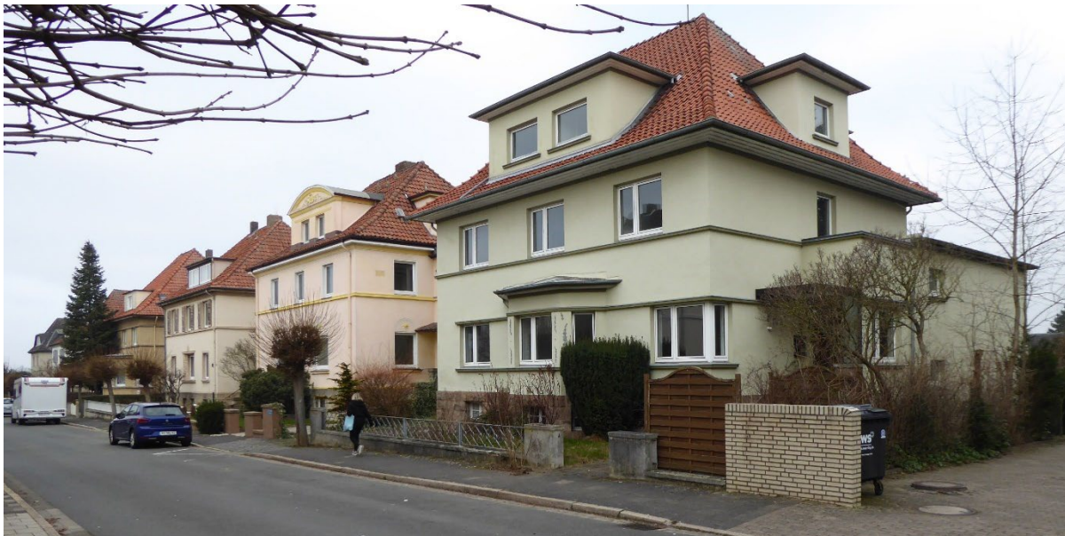
Abb. 2 Hindenburgstraße, Hausnrn. 2 und 4 (vorne) sollen durch Neubebauung ersetzt werden
