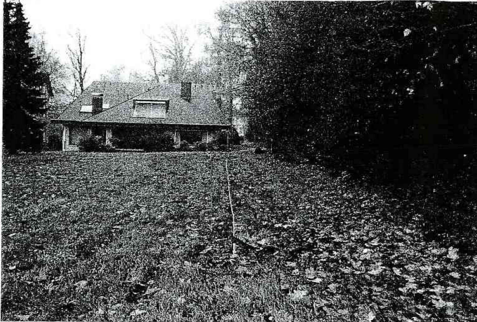
Foto Nr. 1: Blick nach Norden entlang der Baufenstergrenze (markiert durch ein Maßband auf dem Boden).
