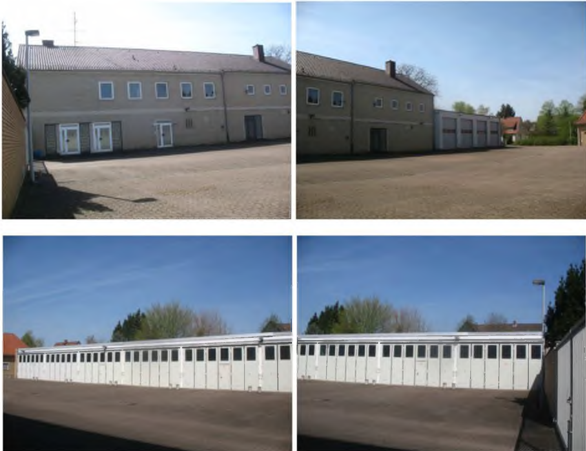
Abbildung 1: Die vier Fotos zeigen beide Gebäude, deren Abbruch geplant ist, oben das südliche ehemalige Verwaltungs-, bzw. Werkstatt- und Lagergebäude mit später angehängter Fahrzeughalle, unten die im Norden liegende große Fahrzeughalle. Beide stehen um den zentralen, großflächig gepflasterten Platz herum. Die Fassaden beider Fahrzeughallen sind teilweise verputzt oder ebenfalls mit bislang weitgehend schadfreien Klinkern versehen.
