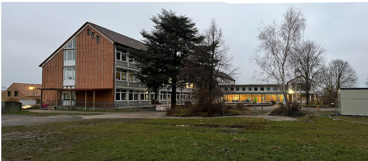
Abb. 1 Blick von Süden nach Norden, vorhandene Restgebäude im Bereich der Bahnhofstraße (Abriss geplant)
