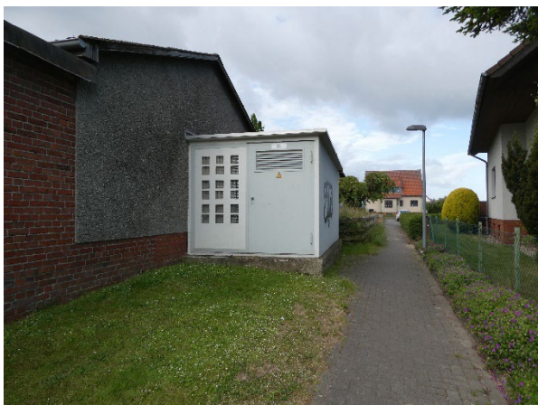
Abb. 2 Blick auf Verteilergebäude mit Fußweg
