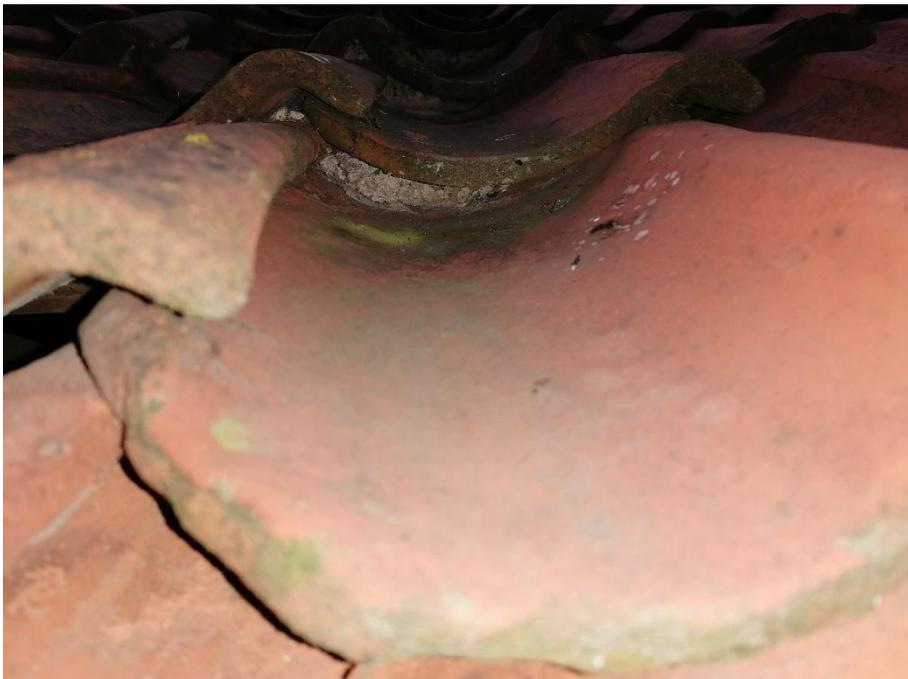
**Abbildung 19:** Detailansicht des Hohlraums unter den Dachpfannen mit Kotspur.
