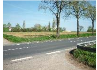
C. 3 Einmündung Cäcilienstraße/B 65
