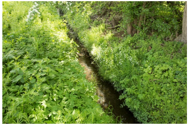
Abb. 7 Büntegraben, mit naturfernem Verbau (Sohlschalen)
