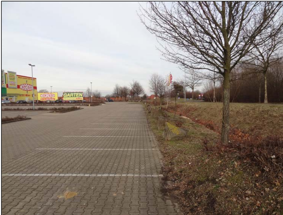
Abb. 4: Östlicher Pflanzstreifen mit Regenwassermulde (rechts) zwischen den Kundenparkplätzen und der Bückethaler Straße (am rechten Bildrand)
