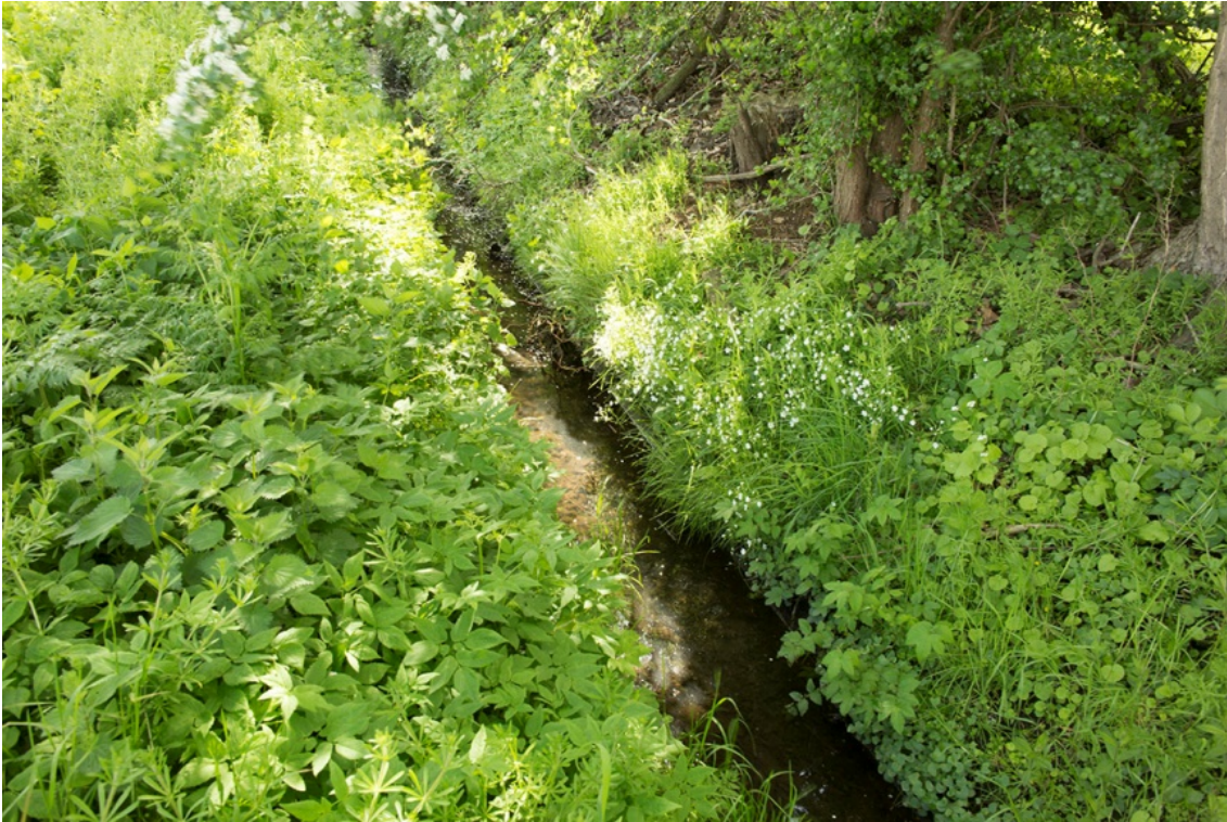
Abb. 7 Büntegraben, mit naturfernem Verbau (Sohlschalen)
