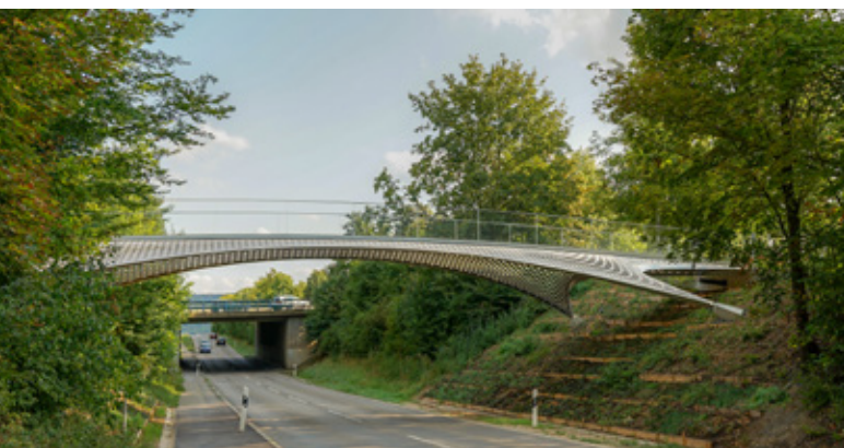
Fußgängerbrücke TRUMPF-Steg in Ditzingen, 2018
